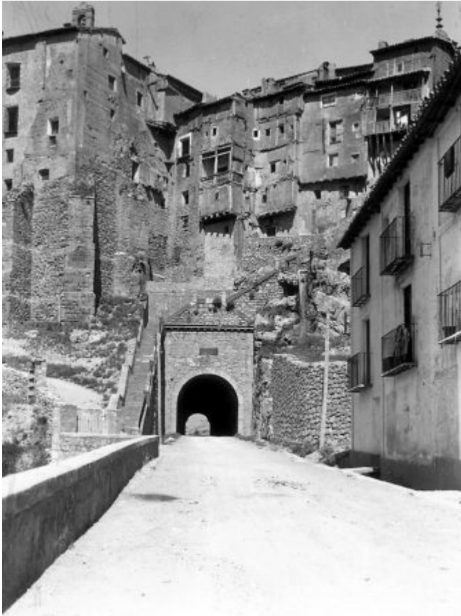
Carretera de Caudé a El Pobo, salvando Albarracín mediante un túnel. Fotografía del Instituto de Estudios Turoleses.
