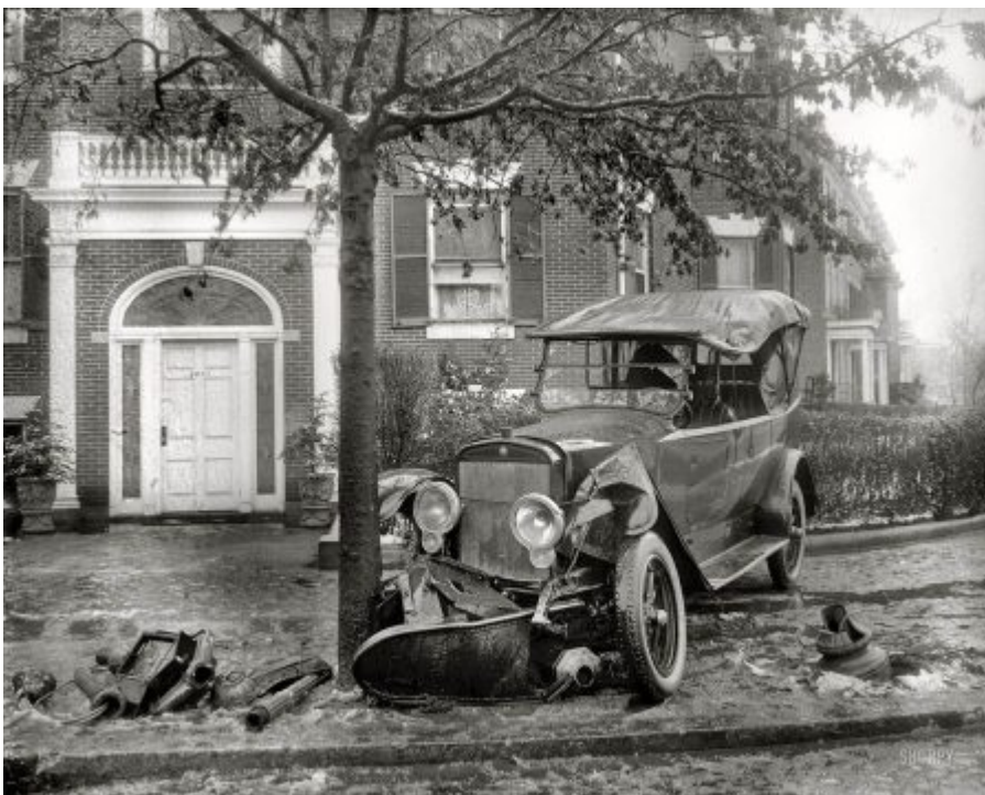
1920. Accidente por salida de la vía y choque contra una farola y un árbol.
