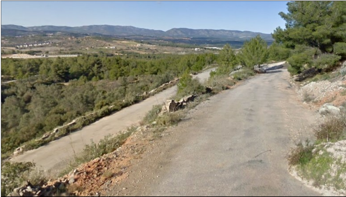
Curvas del "Ragudillo". Primitiva carretera.
