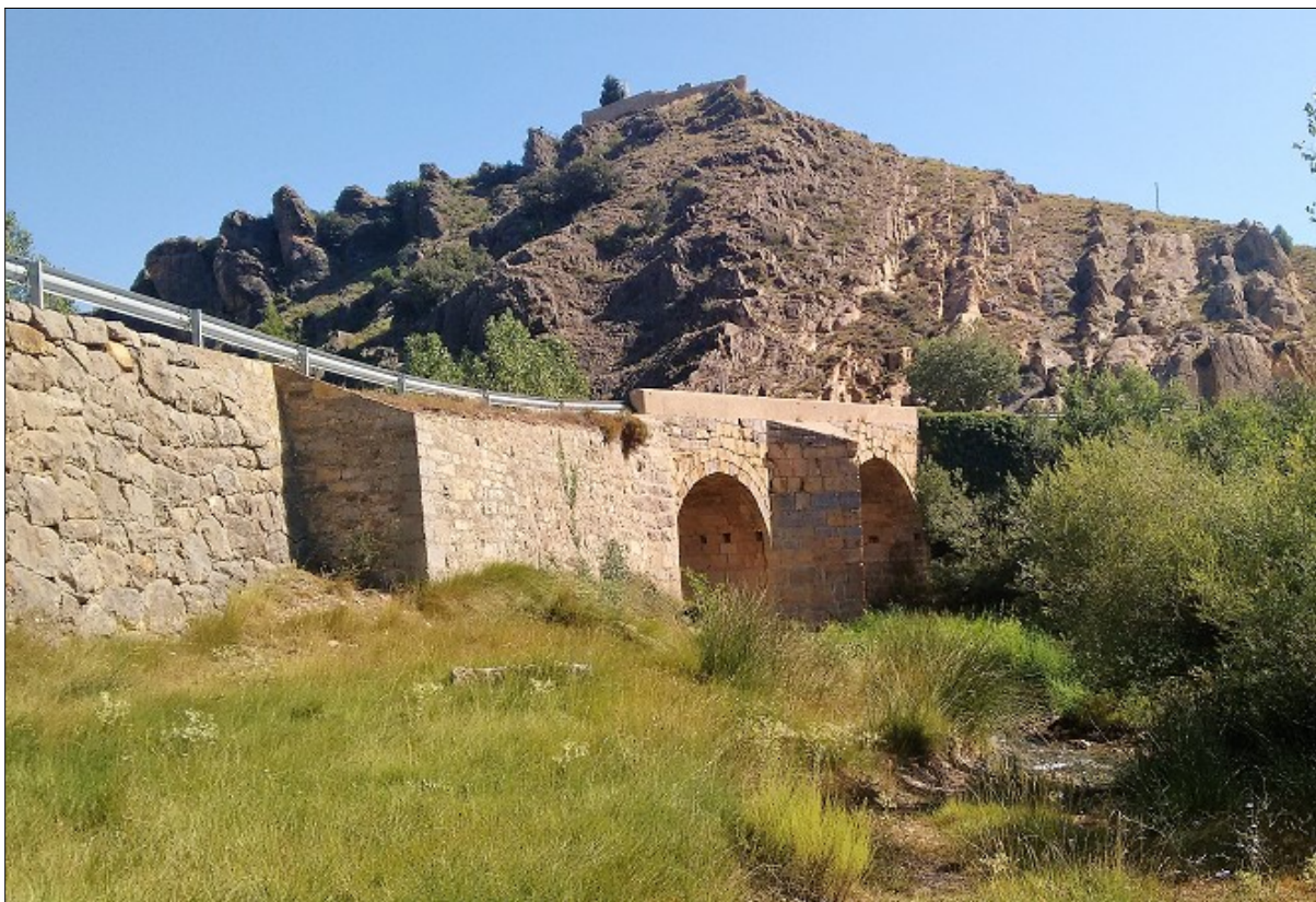
Puente de Albentosa.
