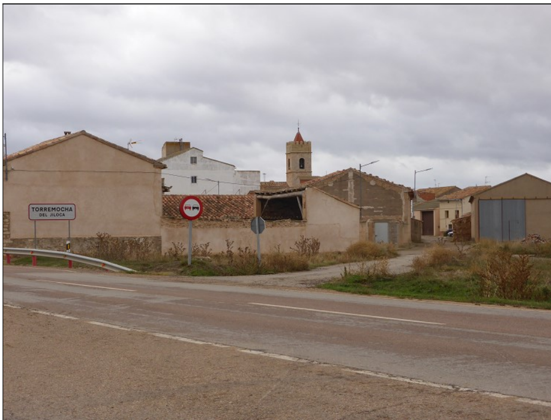
Torremocha del Jiloca. Al fondo, torre de la iglesia de San Cristóbal.
