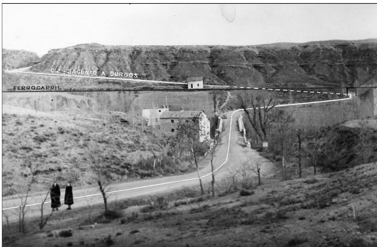
Trazado de la antigua carretera (y probablemente también del camino real) por el Barranco de Valdelobos. Puente y venta de Caparrates. Foto de la década de 1960. Ministerio de Fomento.
