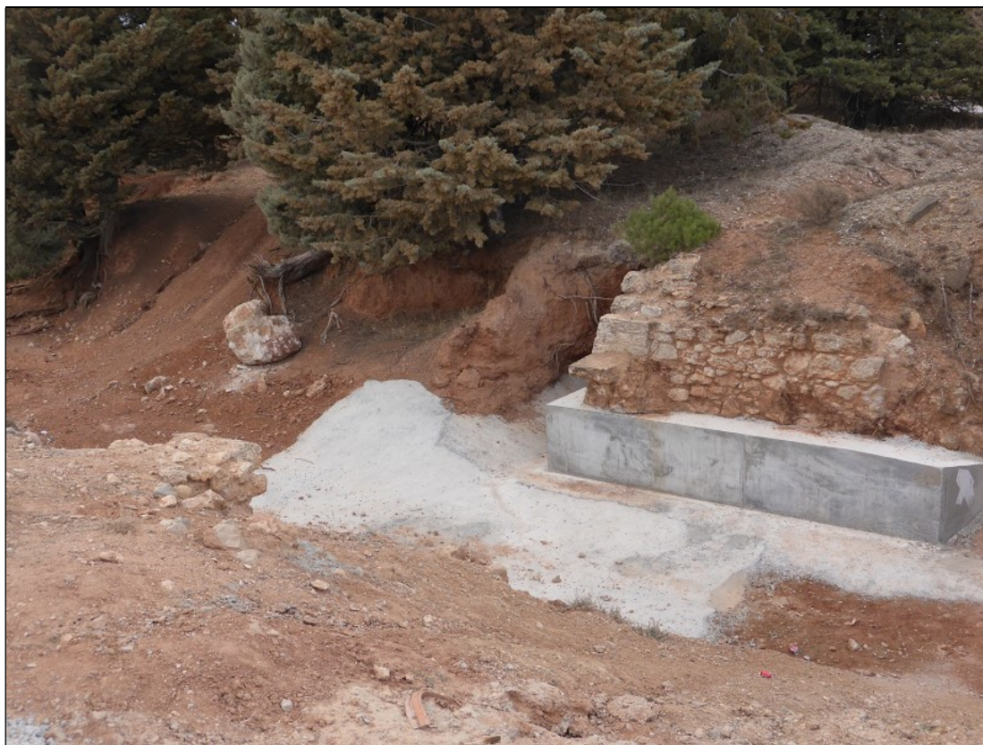
Restos de estribo. Teruel, camino de Fuente Cerrada.
