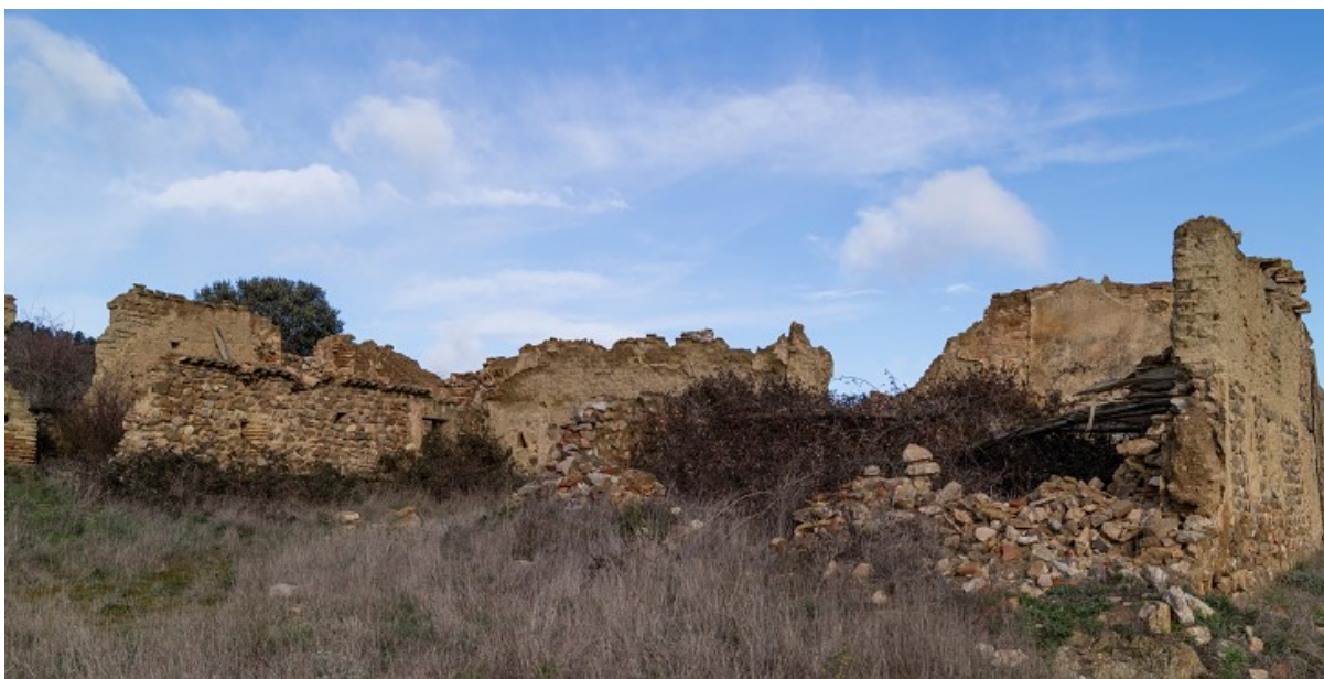
Restos de la venta de San Martín del Puerto (foto de 2016).
