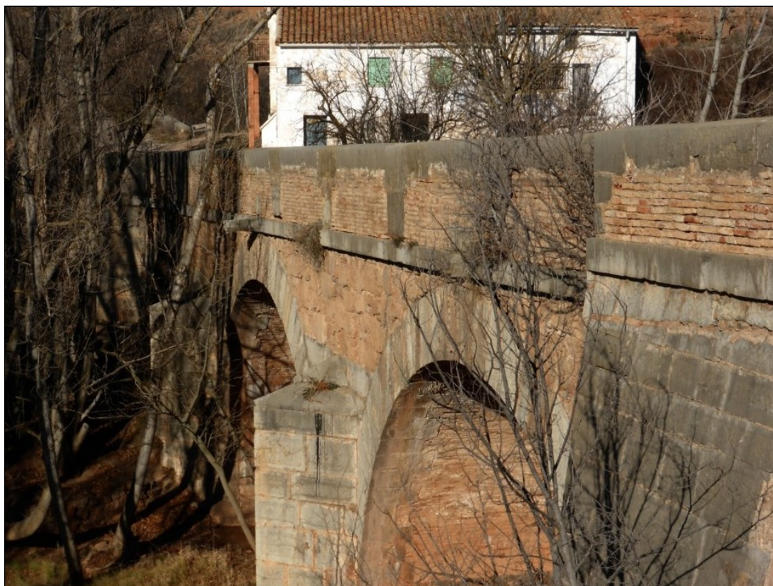
“Sólido puente” citado por Laborde, junto al ventorrillo, entre Teruel y La Puebla de Valverde. En el pretil figura el año de 1802.
