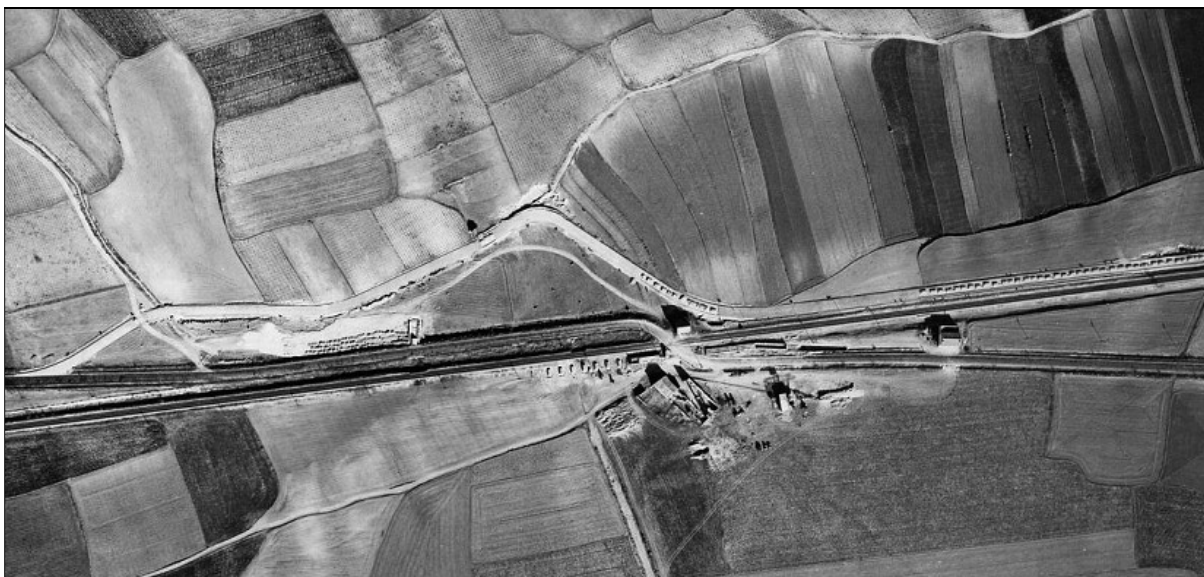
Ventas de Malamadera y del Carril, antes de su demolición completa para la construcción del puente sobre el ferrocarril. Foto aérea de 1964.
