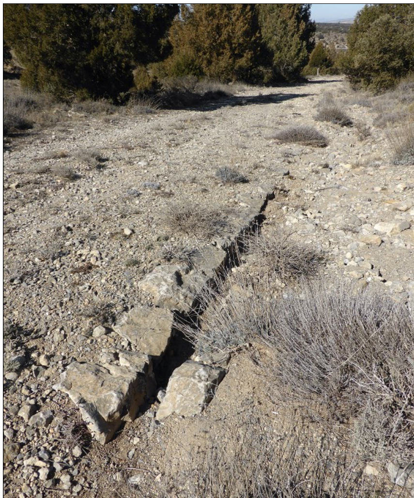
Tramo con bordillos en el margen de la antigua carretera. Puerto de Escandón.
